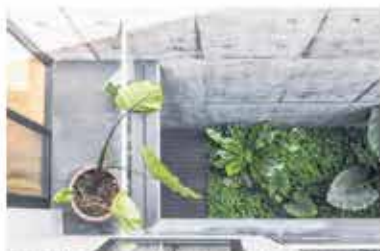
新上望去的露天空间，让美丽的清水泥墙与建筑构造打造“一线天”的美感。
